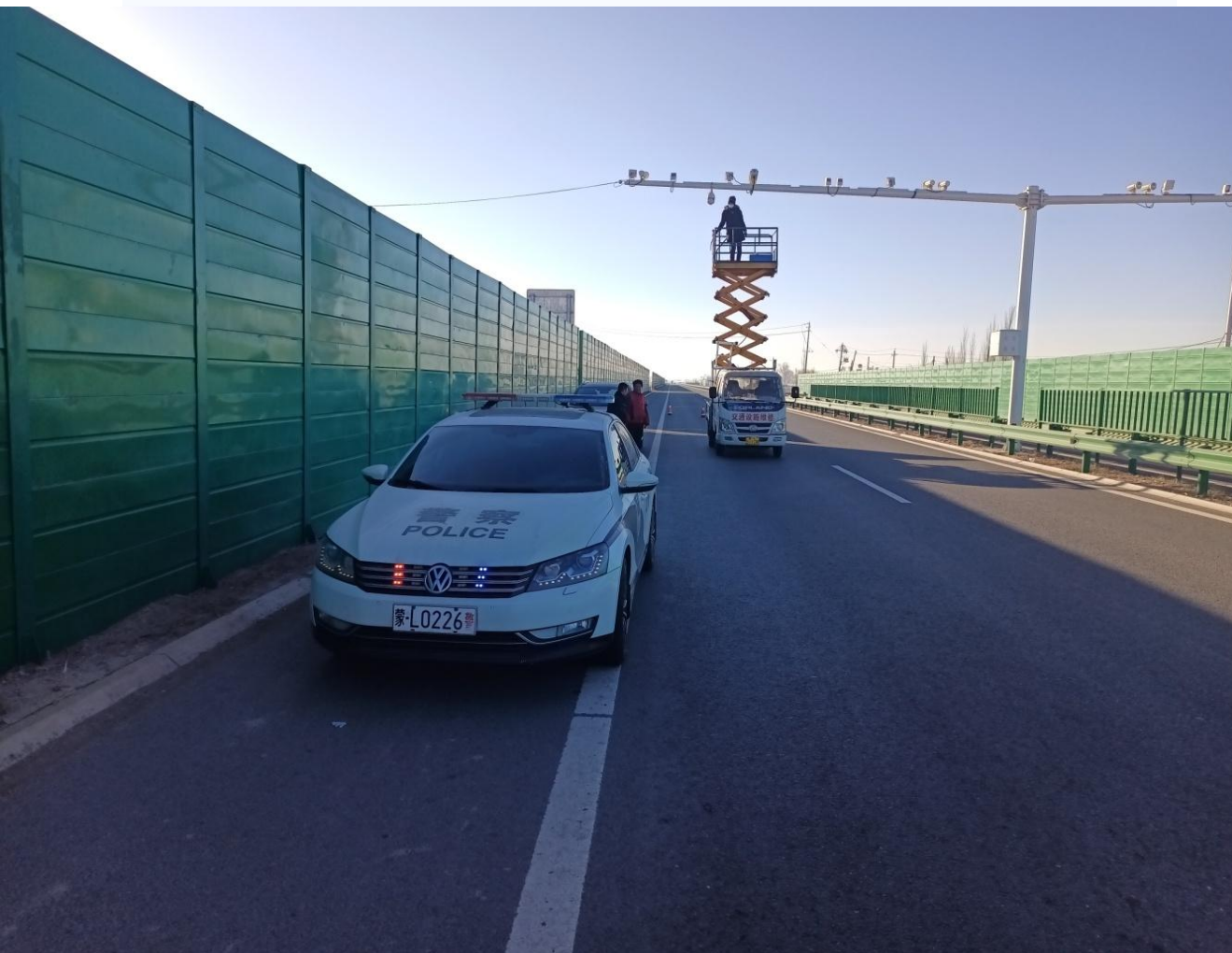
协调厂家技术人员现场调修设备
